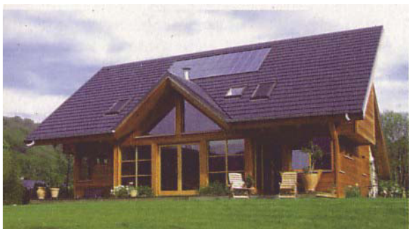
15m 2 de capteurs solaires orientés plein Sud alimentent un système ECS (eau chaude sanitaire) et chauffage avec appoint gaz naturel.
