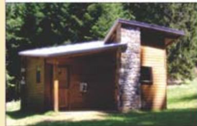
3 Construction d'un bloc sanitaire au Lac du Bouchet
